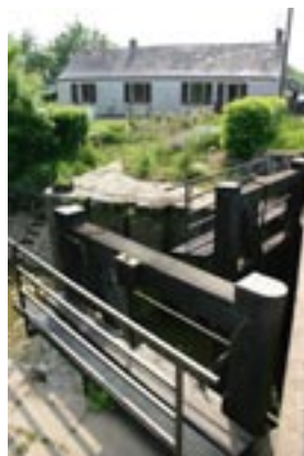
L'écluse du Dareau
